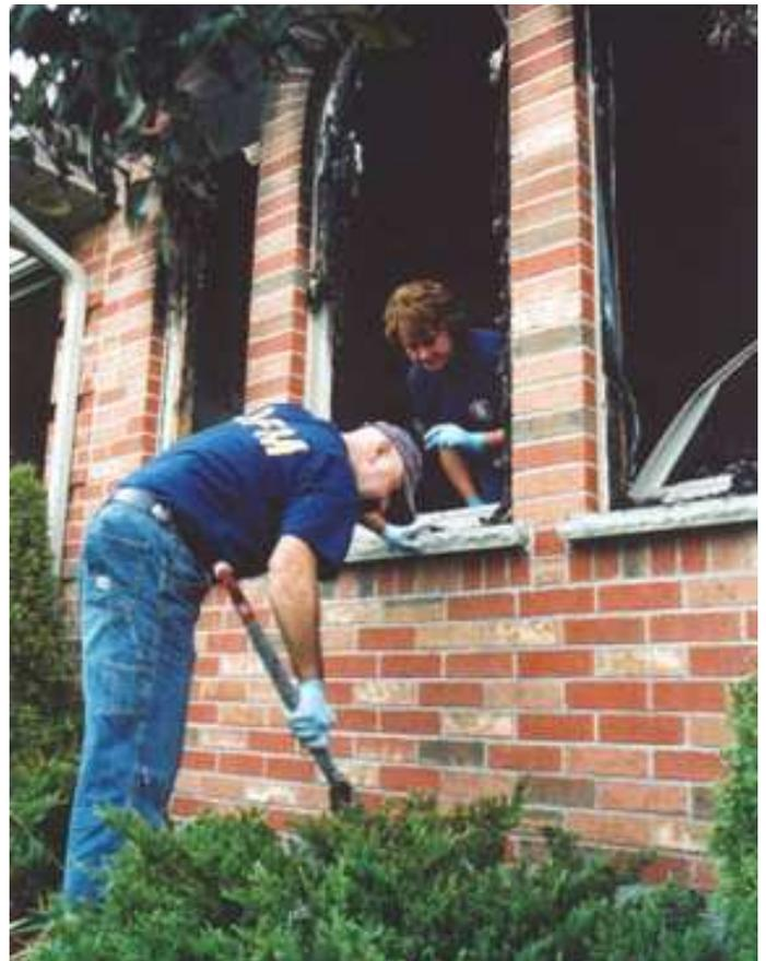
Figura 36.9. Debe inspeccionarse cualquier hueco en la fachada, para ver si han sido forzados, o si han caído cristales al exterior.
