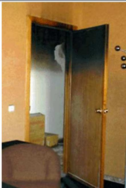
Figura 36.42. El humo se cuele a presión por las rendijas de las puertas, fundamentalmente por la parte superior, tal como se muestra en la fotografía de la derecha, correspondiente a un incendio real, en la que se evidencia que la puerta estaba cerrada.
