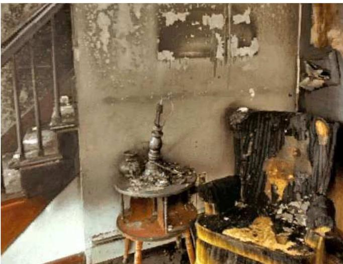
Figura 36.23. Las marcas dejadas por el humo y el calor en la mesa junto al sillón, indican claramente que el fuego estaba por encima de la mesa, ya que la parte inferior de la misma está intacta y la parte superior está quemada.
