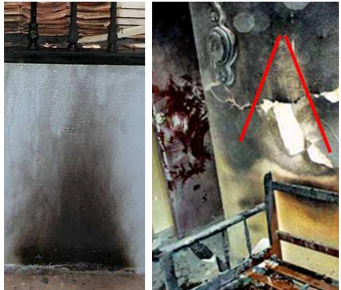
Figura 36.27. A la izquierda marca en V invertida dejada por un líquido inflamable. A la derecha marca en V invertida por un foco elevado, concretamente sobre una mesa que no aparece en la fotografía y el fuego en el respaldo del sofá.
